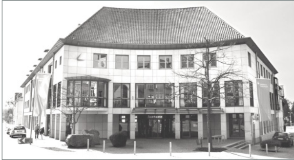
Firmengebäude Sparkasse Duderstadt
